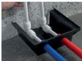
Fig. 38 Cut conduit box for wall termination
